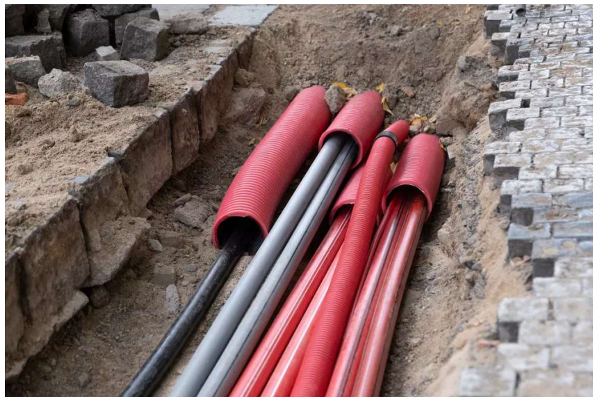
Gambar 5.8. Pemasangan Kabel Bawah Tanah Multi Saluran/ Kabel
