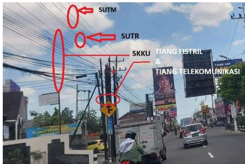
Gambar 4.1. Kondisi SUTM, SUTR, SKKU dan Tang Listrik, Tiang Komunikasi
