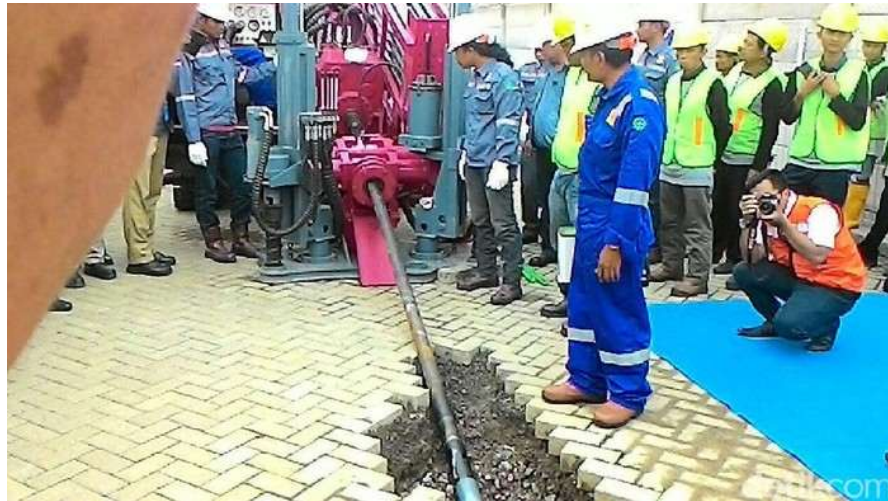
Gambar 5.7. Pemasangan Kabel Bawah Tanah Saluran Tunggal
